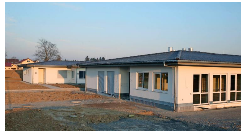
Zwei Zwillingsbauten: das neue Vereinsheim SC Ilsfeld, dahinter der Jugendclub. Für beide Gebäude hatte der Sportclub die Bauherrschafft inne. Fotos: Andreas Veigel
